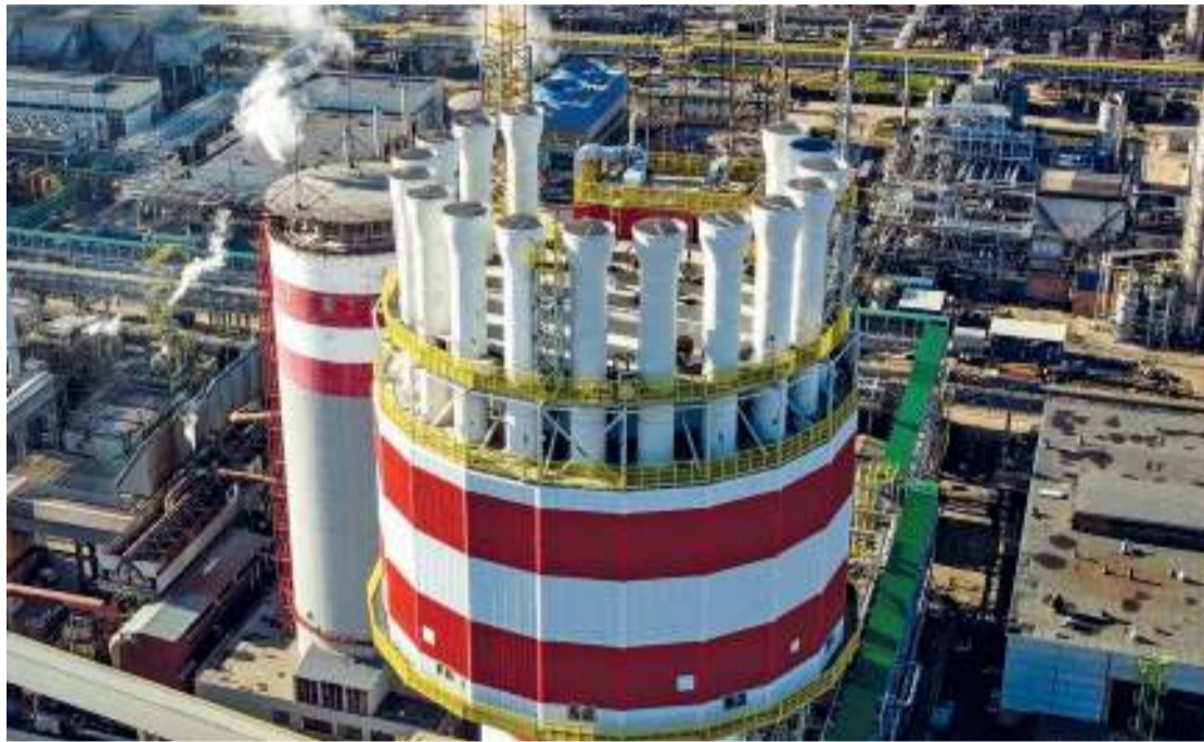
После ввода третьего агрегата карбамида на Тольяттиазоте будут действовать 12 установок для очистки воздуха от пыли и газов
